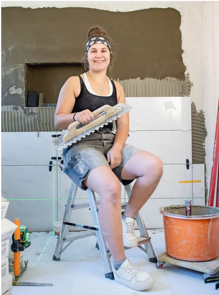
Plattenlegerin Edith Zemp an einem Arbeitsplatz, hier ein Badezimmer. Bild: Boris Bürgisser (Flühli, 18.8. 2025)
